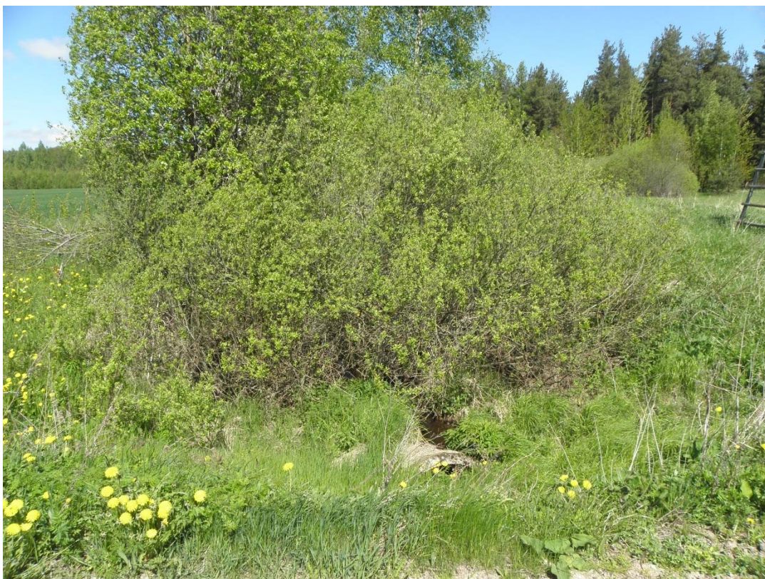
Caurteka uz ūdens notekas (ŪSIK kods 6832533:01) apmēram 7.0 km no ietekas Kūkovā (ŪSIK kods 6832:01). Caurteka bojāta, grāvis piesērējis un aizaudzis.
