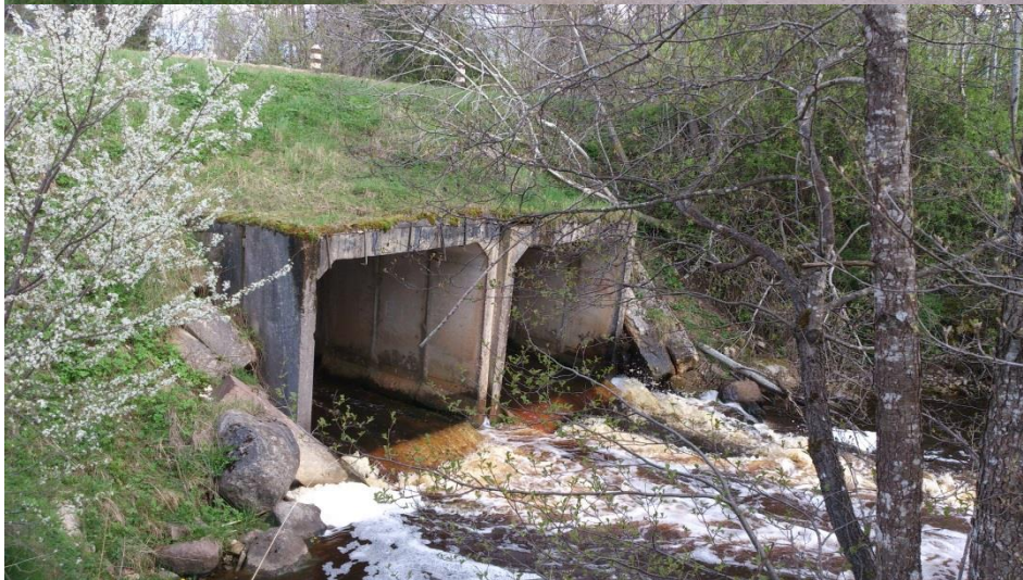
Caurteka/tilts pār Riežupi Rumbeniekos
