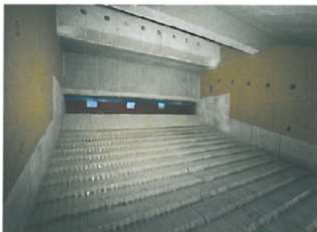
5.1. attēls. Kustīgo ārdū sadegšanas kameras piemērs 15
